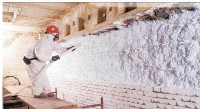
Aplicações em paredes de fornos
